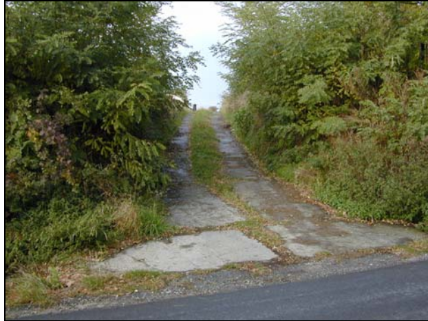
Ryc. 2. Ukształtowanie drogi, na której mógł zaparkować „sprawca”.
